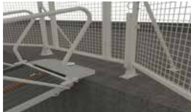
Innfestning på landfundament.
