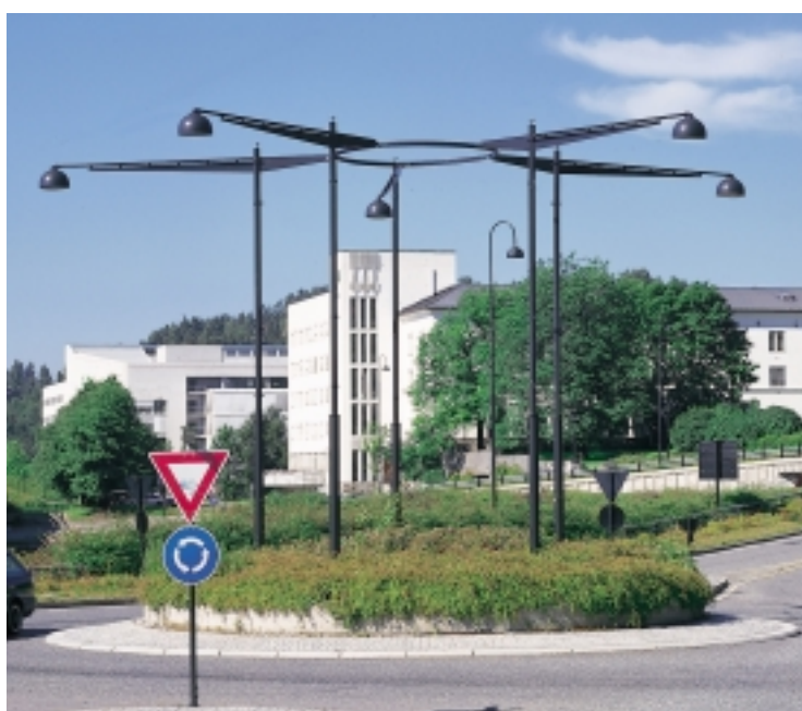
Rundkjøringsmast i Sandvika, Oslo, med Thorn Victor armaturer.
